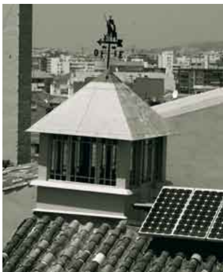
Tejado con mirador y 26 módulos fotovoltaicos.
