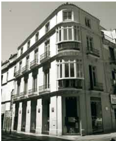
Edificio rehabilitado en Puerta de Buenaventura 3.
