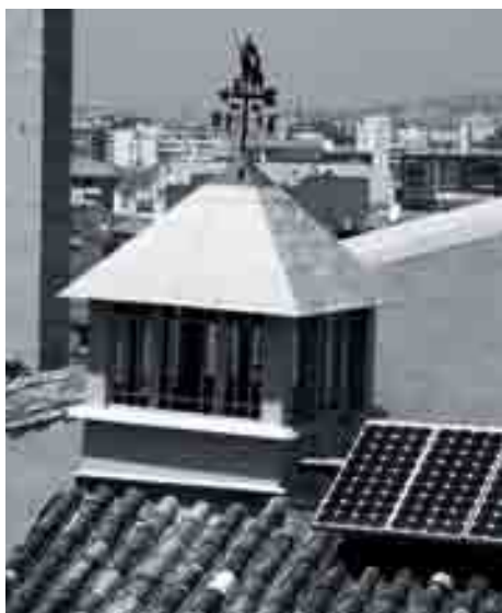
Tejado con mirador y 26 módulos fotovoltaicos.
