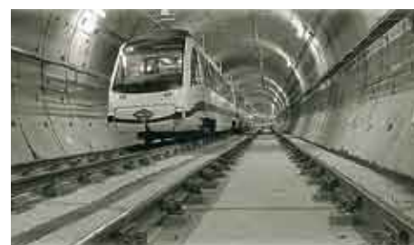
Ampliación del túnel del Metro.
