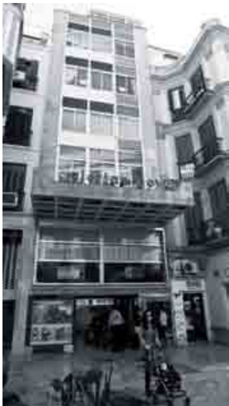
Entrada de Galerías Goya.
